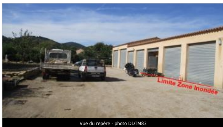
Vue du repère - photo DDTM83
