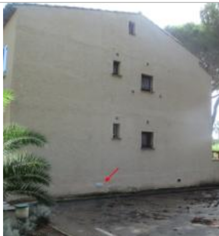
Vue du site - photo DDTM83
