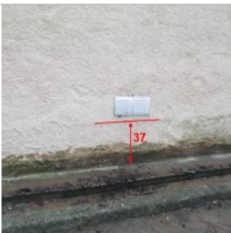
Vue du repère - photo DDTM83
