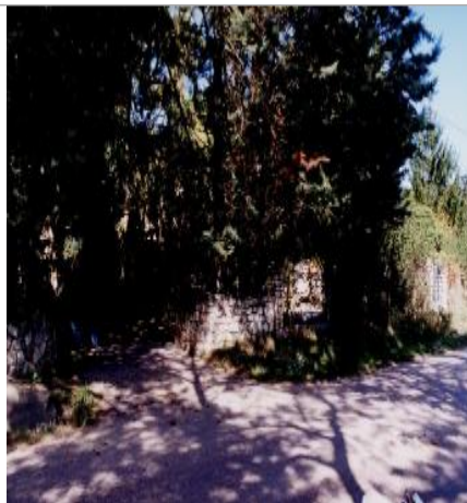
Vue du site - photo DDTM83
