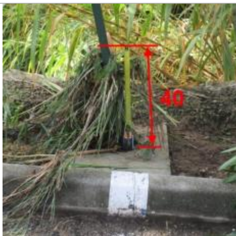
Vue du repère - photo DDTM83
