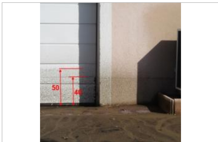
Vue du repère - photo DDTM83
