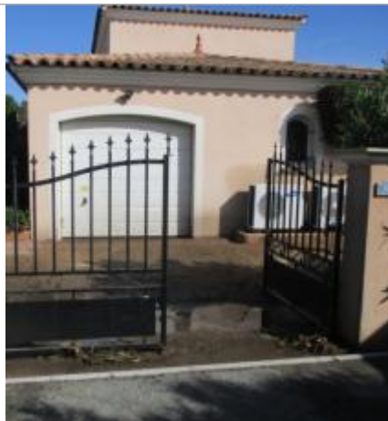
Vue du site - photo DDTM83
