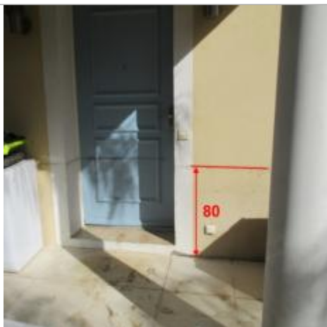
Vue du repère - photo DDTM83
