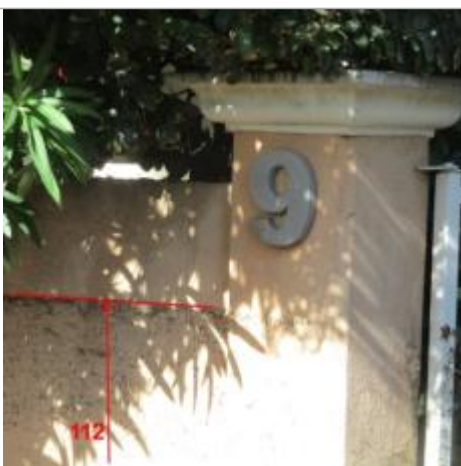
Vue du repère - photo DDTM83
