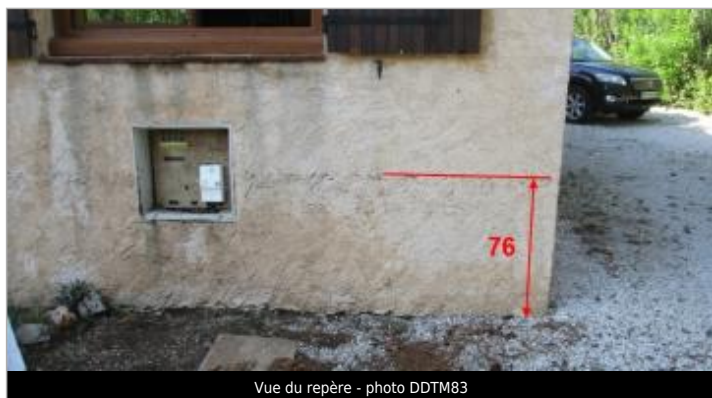
Vue du repère - photo DDTM83
