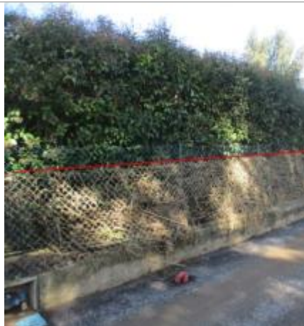
Vue du site - photo DDTM83
