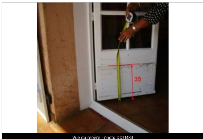
Vue du repère - photo DDTM83
