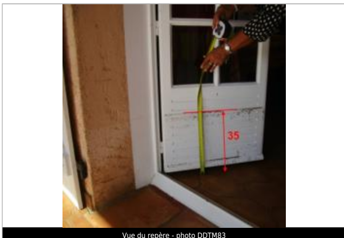
Vue du repère - photo DDTM83
