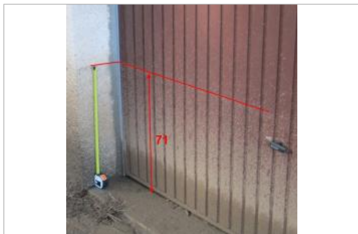
Vue du repère - photo DDTM83
