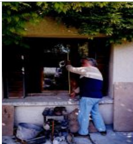
Vue du site - photo DDTM83
