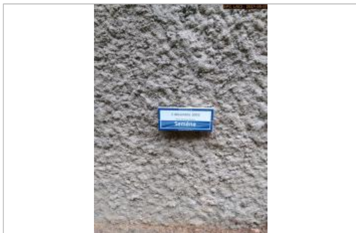
Vue du repère rapprochée en 2021
