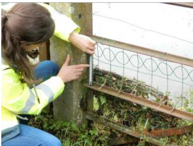
Laisse de crue sur portail du champs à 9 cm/ 2 ème barre horizontal
