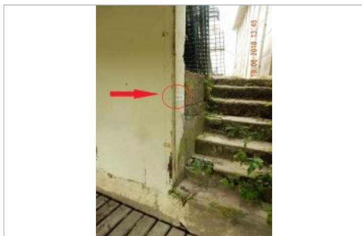
Plaque déposée par les services communaux
