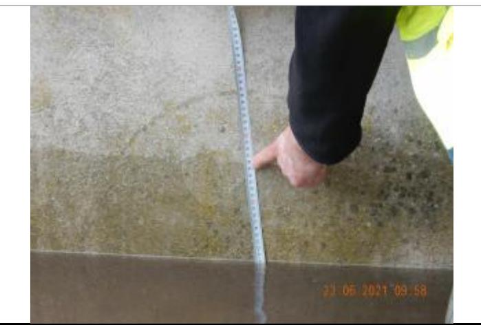
laisse de crue sur mur en béton à 26 cm/sol
