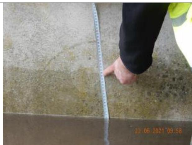
laisse de crue sur mur en béton à 26 cm/sol
