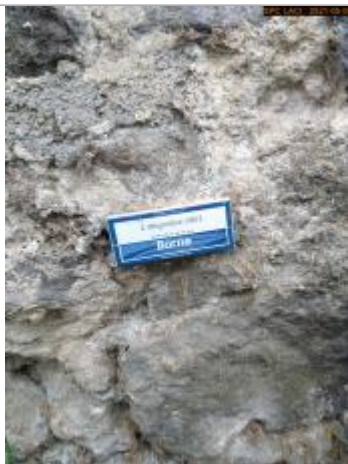
Vue du repère rapprochée en 2021
