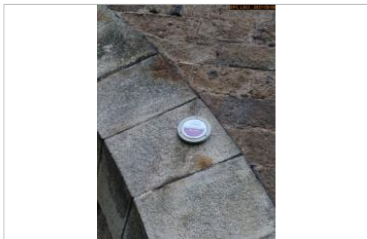
Vue du repère rapprochée en 2021
