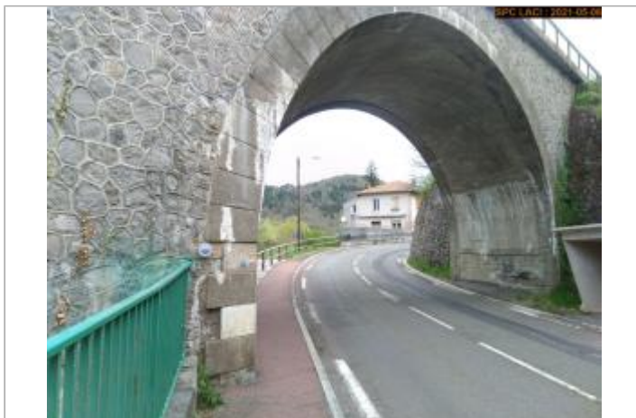
Vue du site côté amont Loire en 2021
