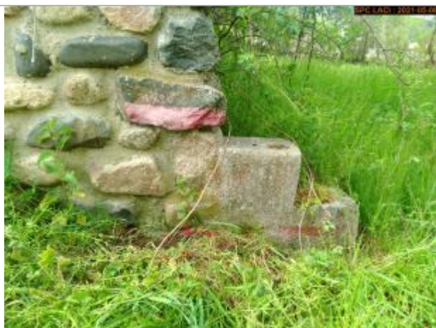
Vue du repère rapprochée en 2021
