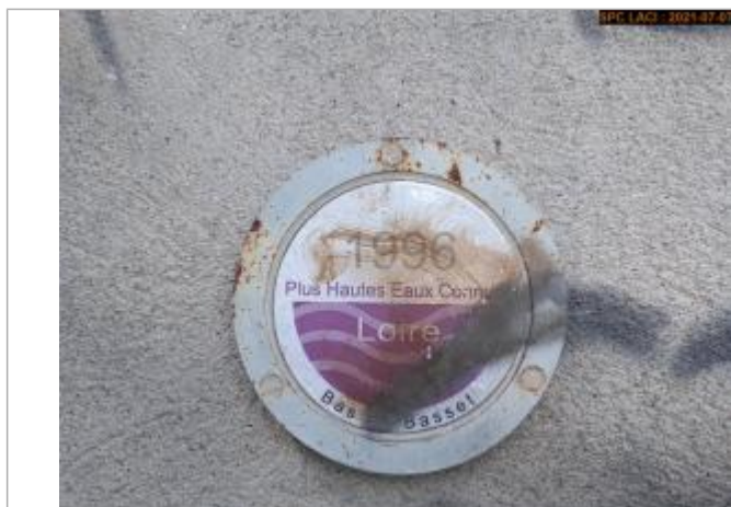
Vue du repère rapprochée en 2021
