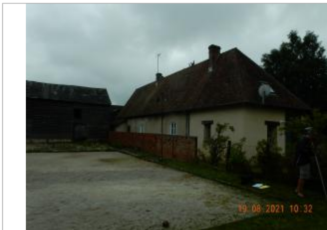
1 impasse du Fort sur clôture au fond du jardin
