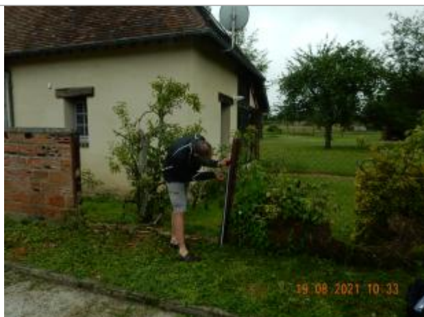
laisse de crue à 83 cm/ au pied de la clôture
