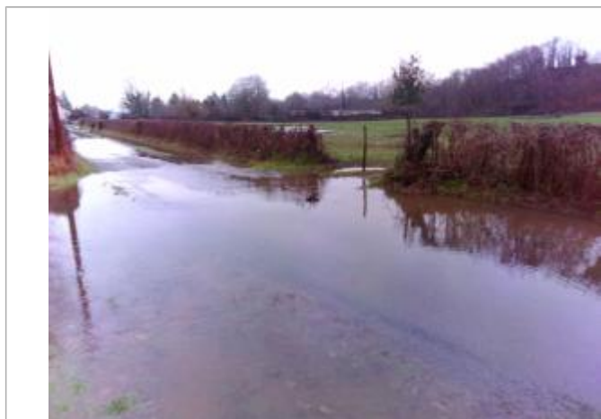
Photo prise de vue le 15/01/2021 à 16h40
