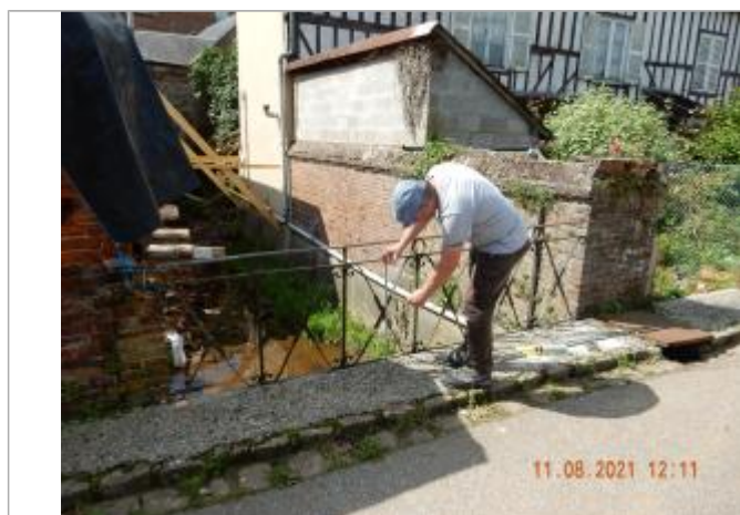
l'eau à atteint le niveau supérieur du croisillon central du garde corps
