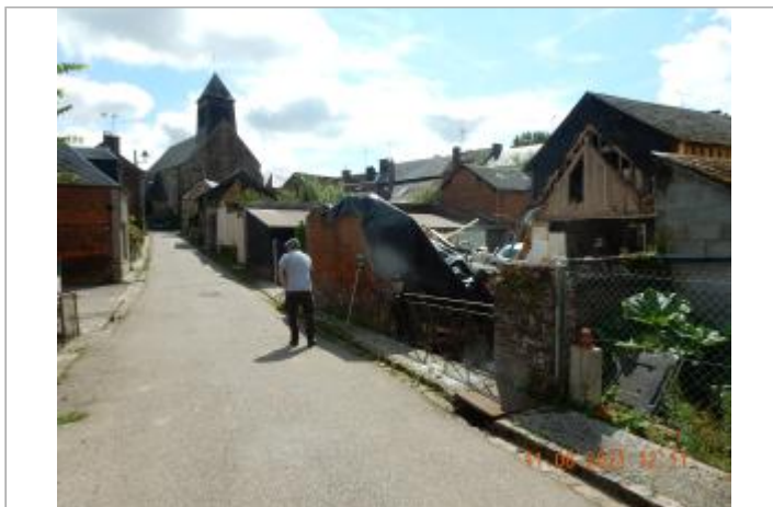
garde corps du pont rue Homo
