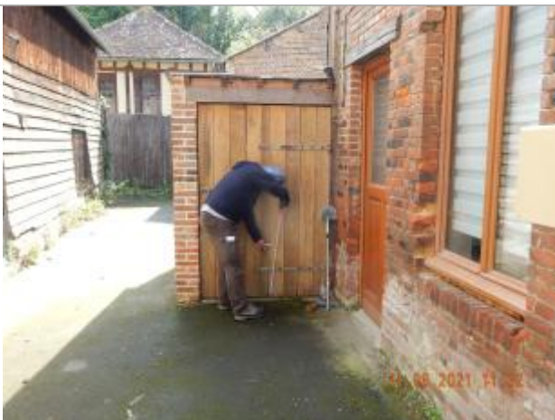
Laisse de crue sur mur cabane à 59 cm/sol
