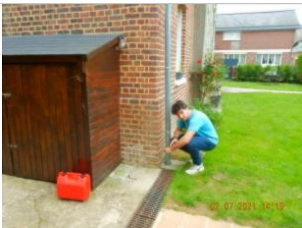
laisse de crue sur mur en brique
