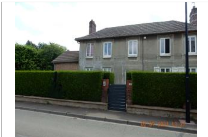
Mur de brique sur la façade Nord du 3 rue de la Laiterie
