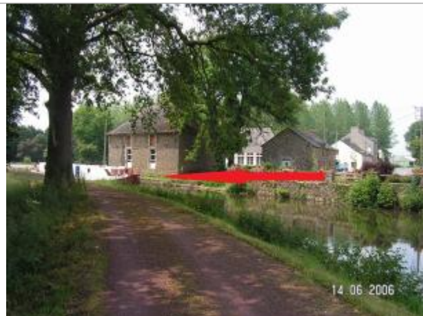
Bâtiment communal abritant l'ancienne station hydrométrique
