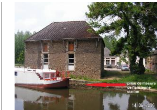
Bâtiment abritant la station et prise de mesure du niveau de l'eau
