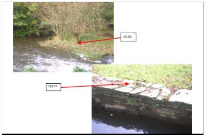
muret au moulin d'Uzel
