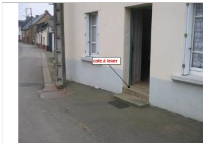
porte d'entrée du n°10 à Pont Favrol
