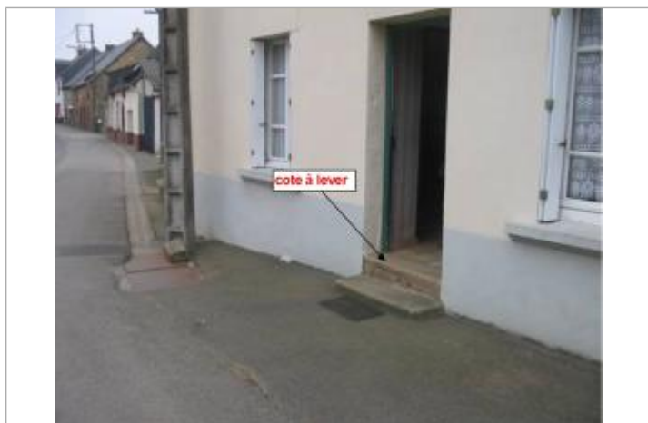
porte d'entrée du n°10 à Pont Favrol
