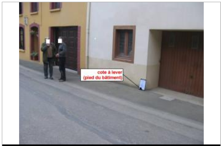
Pied du mur coté gauche de la porte de garage au n°13
