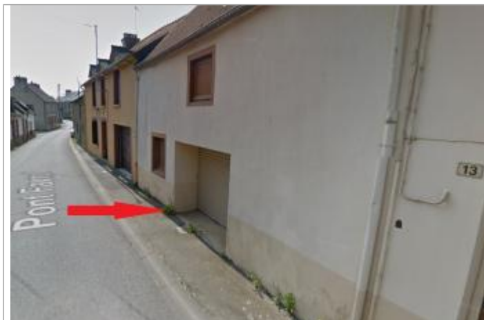
Maison au n°13 Pont Favrol - porte de garage
