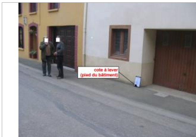
Pied du mur coté gauche de la porte de garage au n°13
