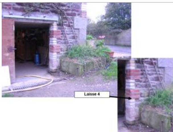
Repere sous la seconde rangée de brique rouge en partant du sol
