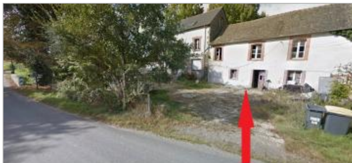
Maison d'habitation à La Gare sur la RD52, rive gauche
