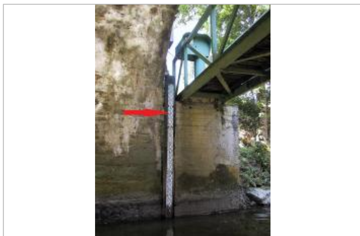
Echelle limnimétrique de la station du Lié à La Prénessaye
