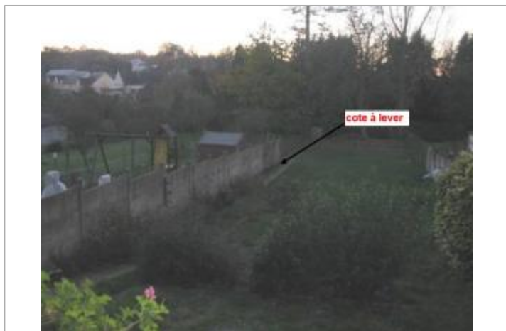
Cloture béton à l'arrière de la maison
