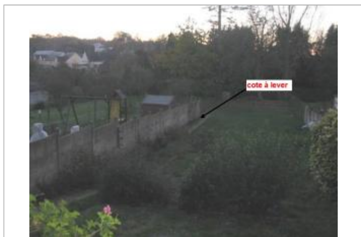
Cloture béton à l'arrière de la maison
