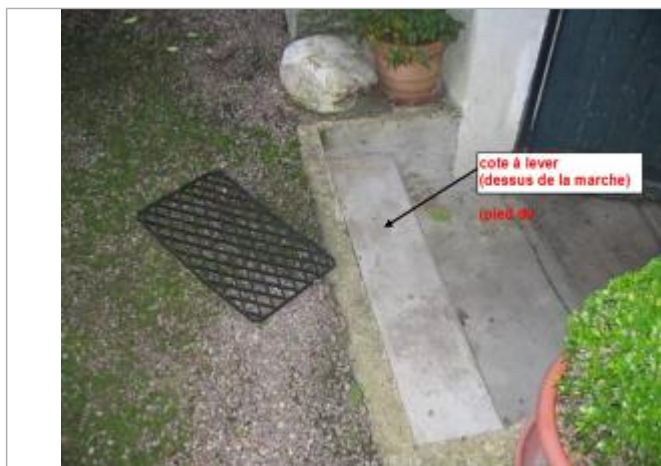
escalier d'accès à la cave de la maison
