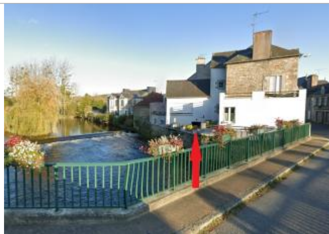
Maison au 1 rue de la Madeleine
