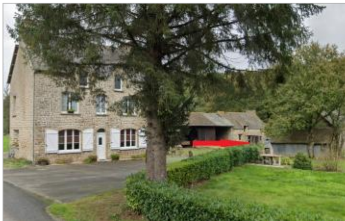
Bâtiment de ferme à la Bichoterie
