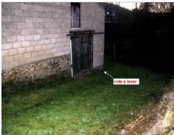
angle du bâtiment coté rivière en 2003
