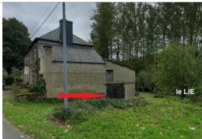
Bâtiment au Gué Jouan près de la RD1
