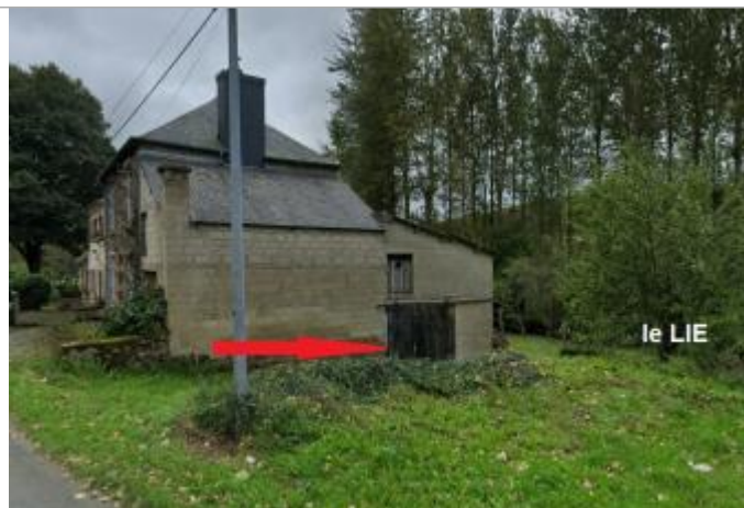
Bâtiment au Gué Jouan près de la RD1
