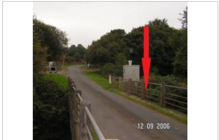
Station hydrométrique de l'Hyères à Trébrivan
