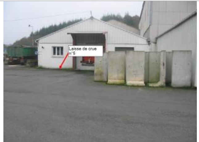
hangar de l'accueil de l'usine agro-alimentaire
