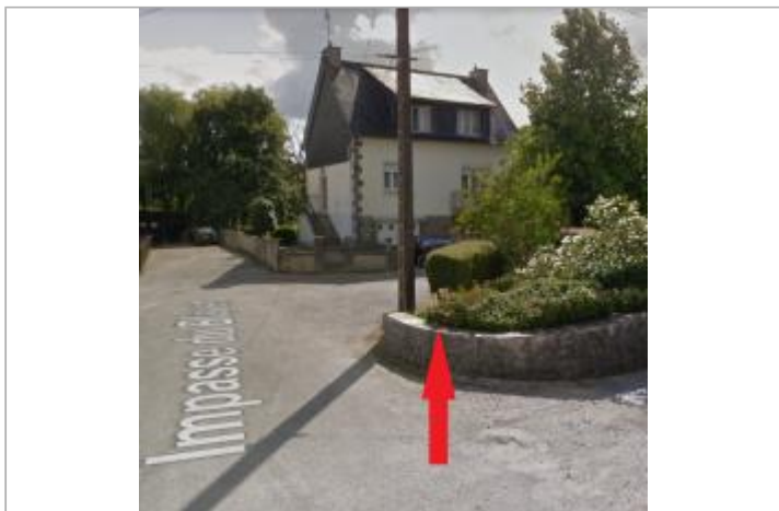
Dessus du muret au 3 impasse du Blavet
