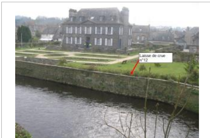
Mur de protection de la mairie de Gouarec
