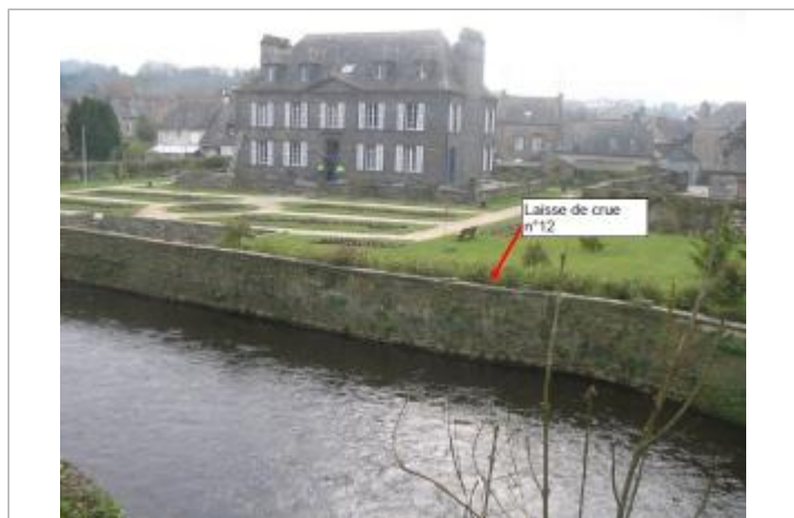
Mur de protection de la mairie de Gouarec
