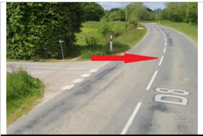
RD 8 au niveau du hameau du Bois Joli
