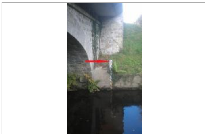
Echelle limnimétrique à l'ancienne station du Blavet à Plounevez-Quintin
