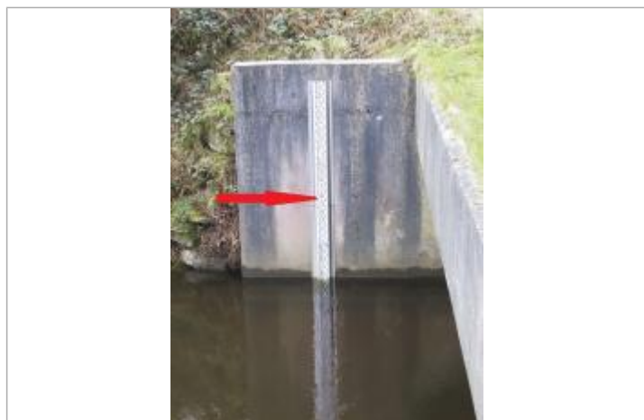
Echelle limnimétrique à la station du Blavet à Lanrivain
